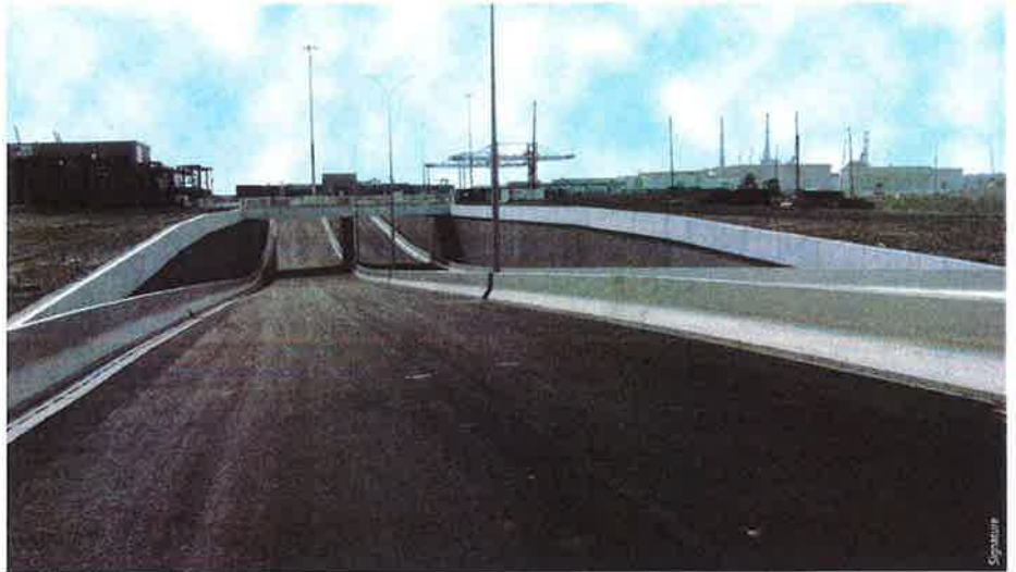
Glissières de type DBA (glissière double en béton adhérent) et GBA (glissière en béton adhérent), chantier Port 2000, au Havre.
